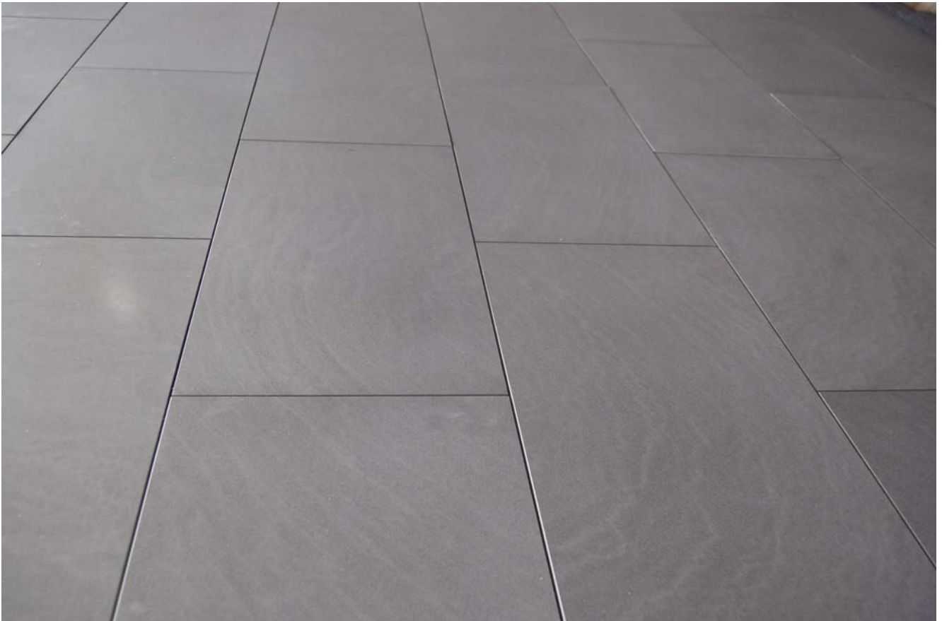
Particolare pavimento - Flooring detail
